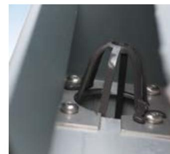
Gouttières équipées de crépines pour un bon écoulement des eaux pluviales
