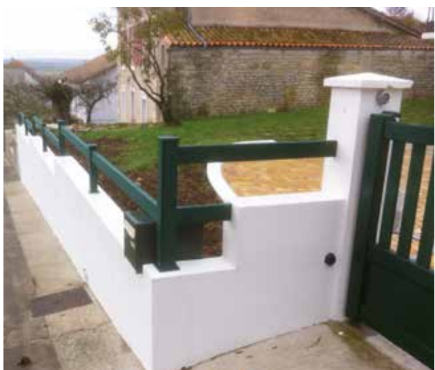
Clôture 1 lisse en escalier
