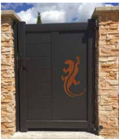
Superposition de 2 tôles découpées sur une tôle pleine centrale. Motifs en couleur possible.
