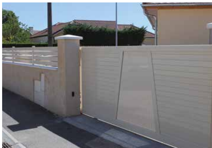
Ensemble Shan avec 41 mètres linéaires de clôture 4 lisses
