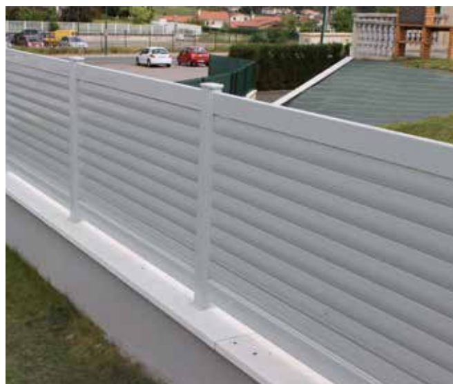
Occultation de l'extérieur tout en laissant passer le vent.
