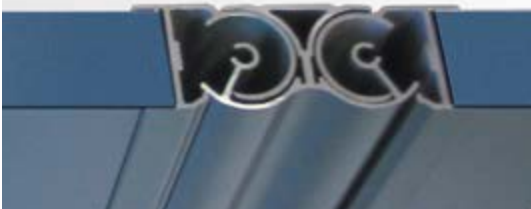
Panneaux sandwichs isolants de 40 mm. Double articulation anti-pince doigts pour portillon
