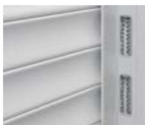
Capot de ressorts de traction avec regard pour permettre le contrôle de l'équilibrage.
